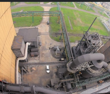
Instalacja odpylania gazu nadmiarowego.
