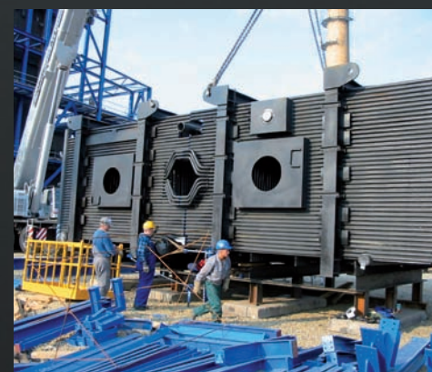
Elektrociepłownia Elsterwerda (BRD), prace montażowe.
