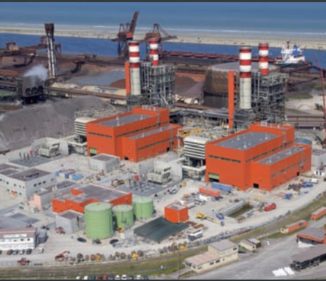
Elektrownia Dunkierka we Francji.
